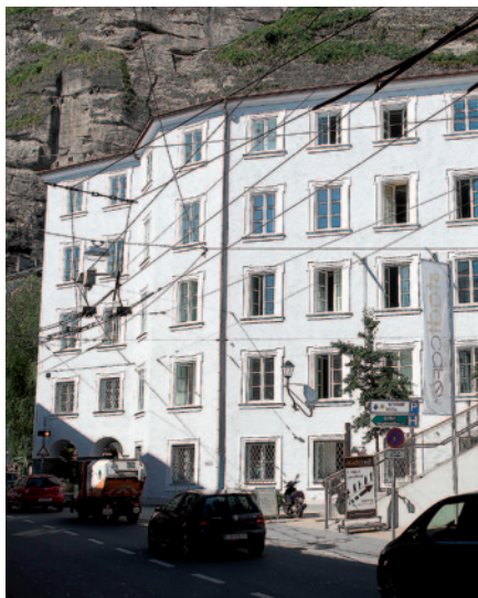
В правительственном здании в старой части города Зальцбурга недавно был проведен капитальный ремонт.
