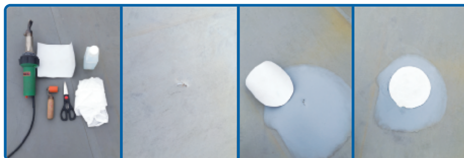
Рисунок 18. Ремонт поверх гидроизоляционного слоя.
