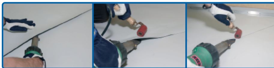
Рисунок 17. Ручная сварка методом в «три этапа».
